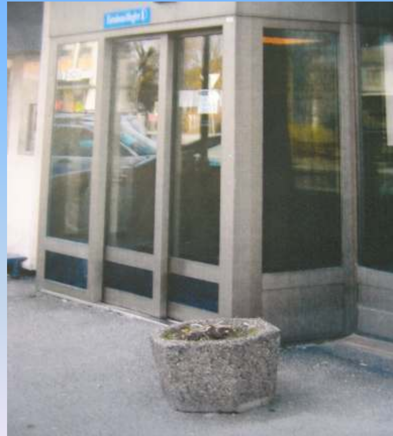
Foto: Øyvind Holand
