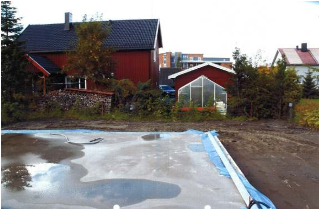
Bilde vedlagt svarbrev fra Vinne Bygg og Eiendom AS – Tatt i retning Feskarvegen 14, eiendommen til Sidsel Deraas og Halstein Prestmo
