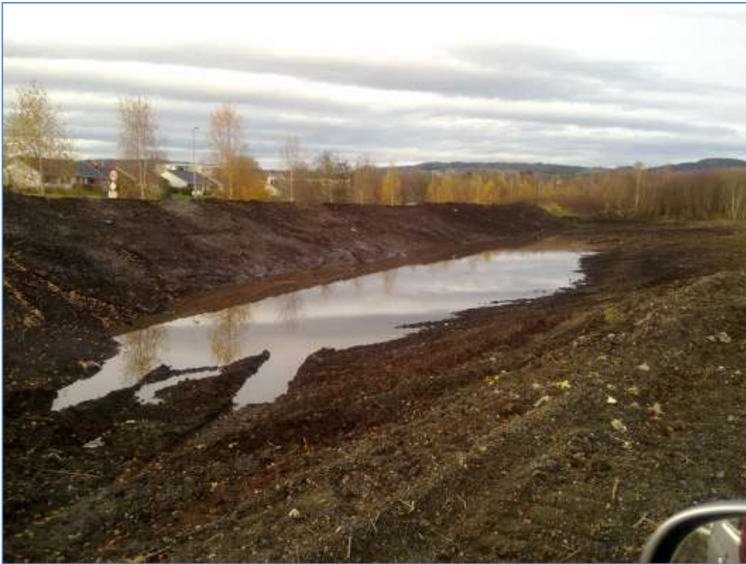
Grunnvann ved støyvoll mot Fv 757.
