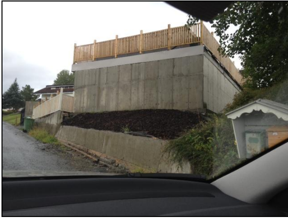
Fasade mot veg
